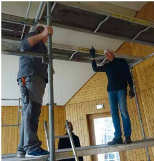
• Installation de la climatisation à la chapelle
