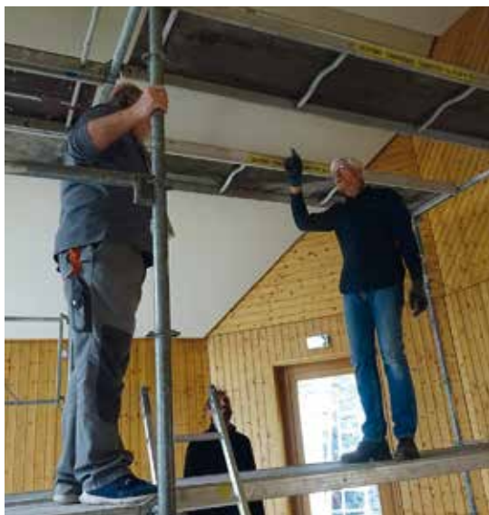
• Installation de la climatisation à la chapelle
